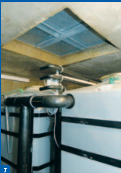
6- Toutes les canalisations sont réalisées en polyéthylène soudé à chaud par contact ou par manchons à fusion par résistance électrique.
