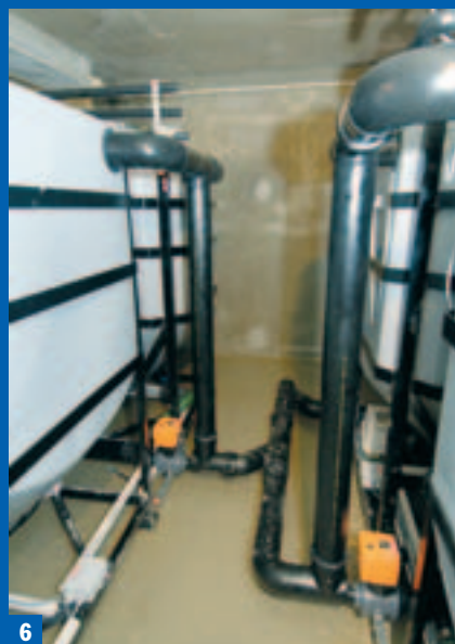
6- Toutes les canalisations sont réalisées en polyéthylène soudé à chaud par contact ou par manchons à fusion par résistance électrique.
