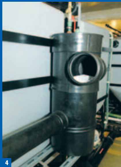
4- Première phase de traitement biologique. Les eaux sont filtrées avant d'être soumises à une digestion bactérienne durant 6 heures. Les bactéries se fixent sur des petits morceaux de mousse synthétique maintenus constamment en mouvement par l'introduction d'oxygène qui dope leur capacité à consommer la charge polluante.
